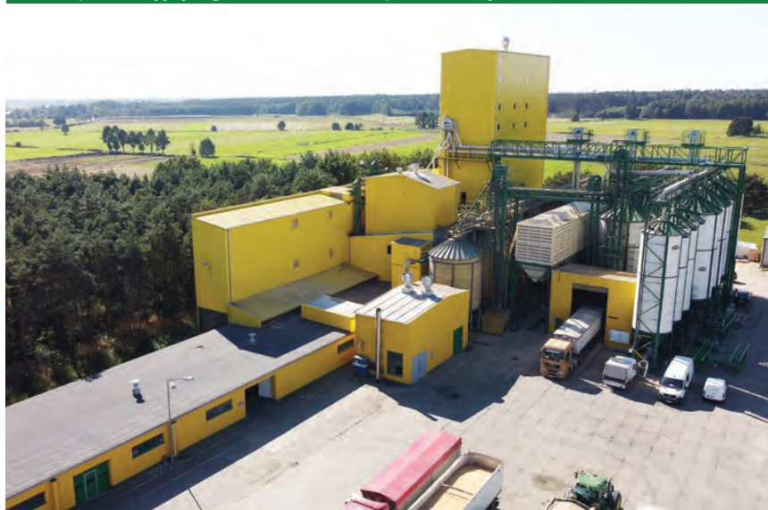
Zakład produkcyjny Agrifirm Polska w Topoli Wielkiej
